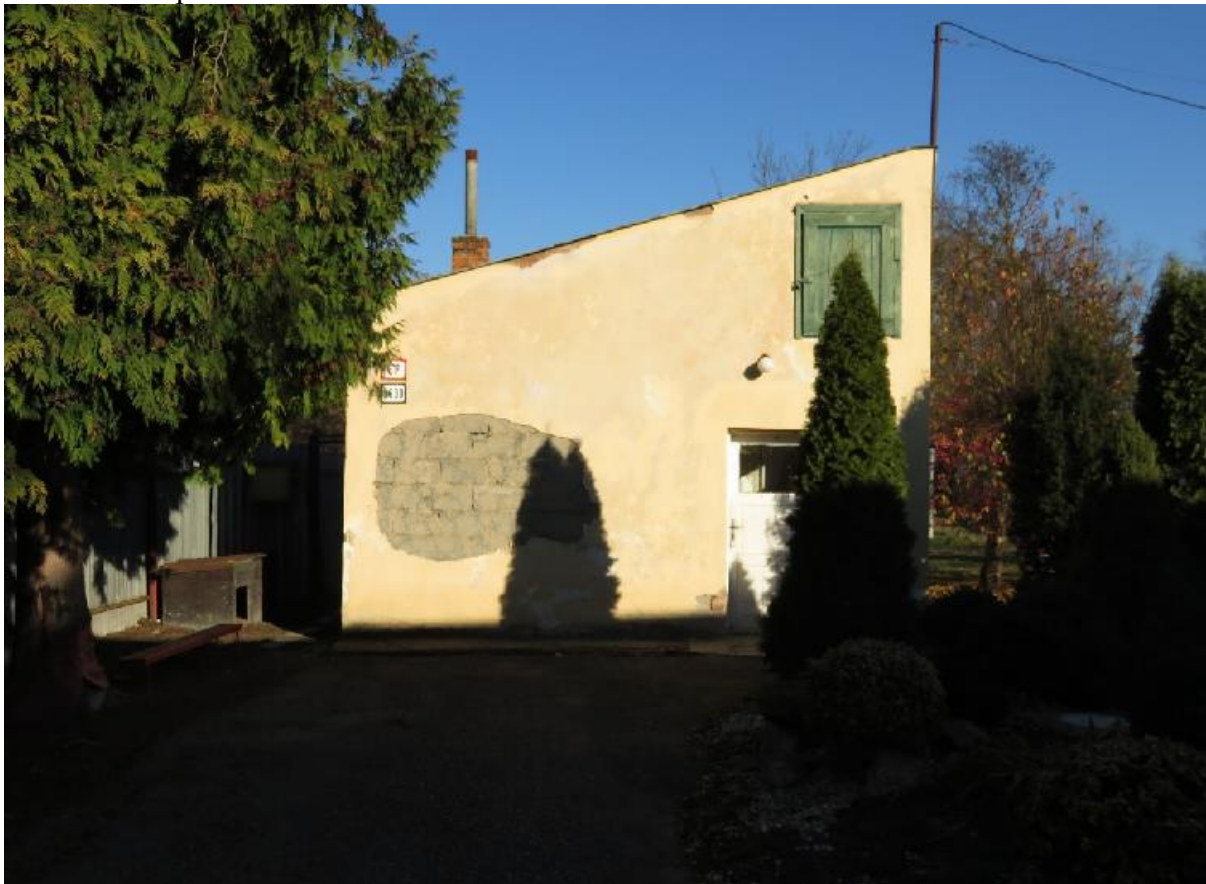
Budova manipulačného skladu
