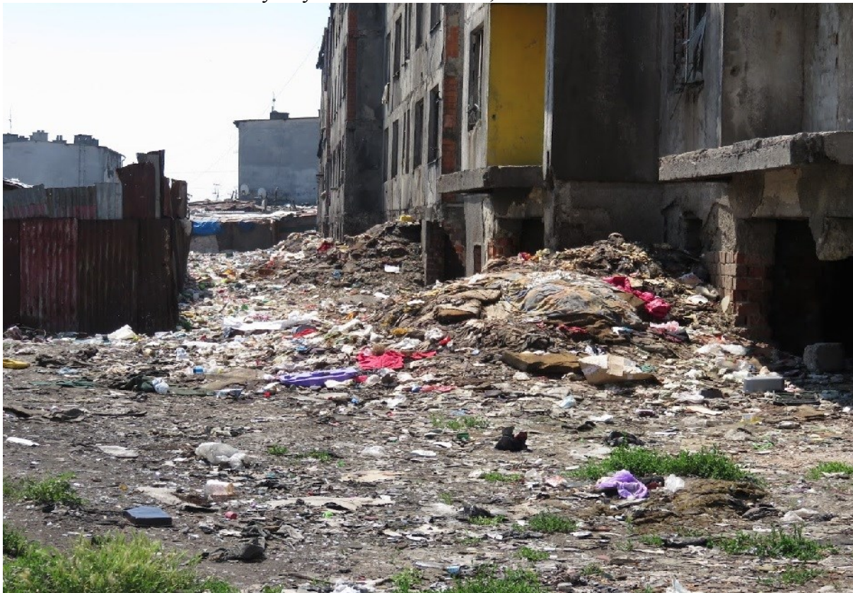
Obr. 9 – Čierna skládka za bytovými domami č. 2167, 2205 a 2208
