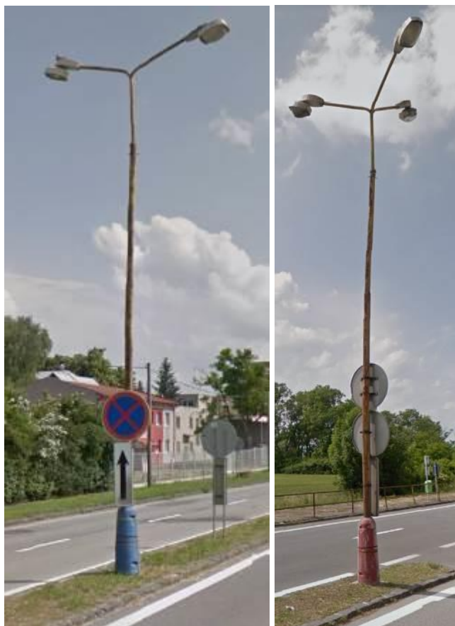
Obr. 8 Skorodovaný stožiar a narušená statika výložníka so svetidlami
