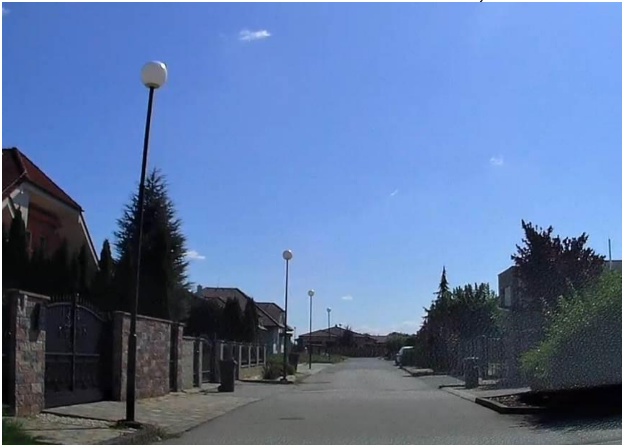
Obr. 14 Svietidlo typu „Globe“ – svietidlo nesvietí na miesto, kam by malo
