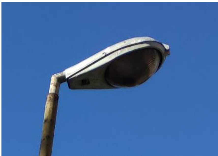
Obr. 2 Najrozšírenejšie svietidlá v sústave typu "TV" znečistenie a korózia svietidla, materiálne opotrebovanie
