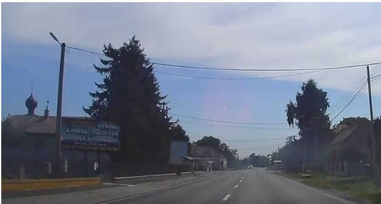
Obr. 16 Nesprávne natočenie svietidla mimo osvetľovaný priestor
