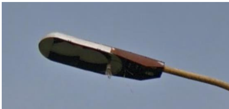
Obz. 3 Fyzicky opotrebované svietidlá typu "HR", prekročené hranice životnosti svietidiel
