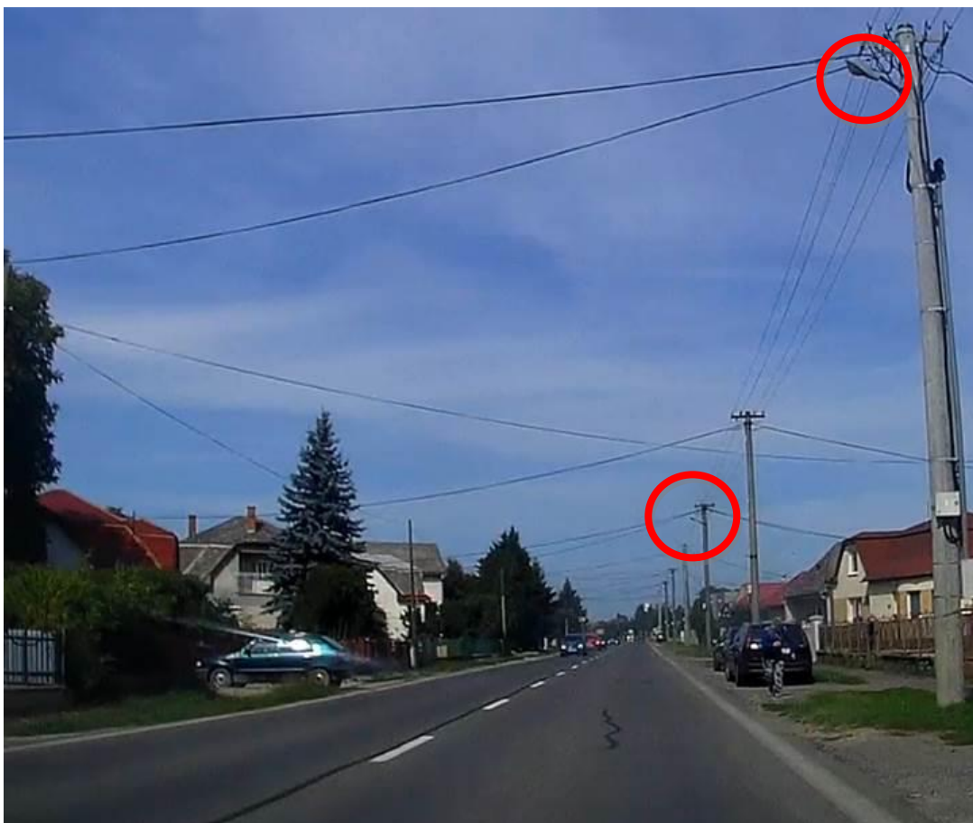
Obr. 13 Veľké rozostupy medzi svietidlami – vzdialenosť okolo 60 - 65 m medzi stožiaru – Milhostov
