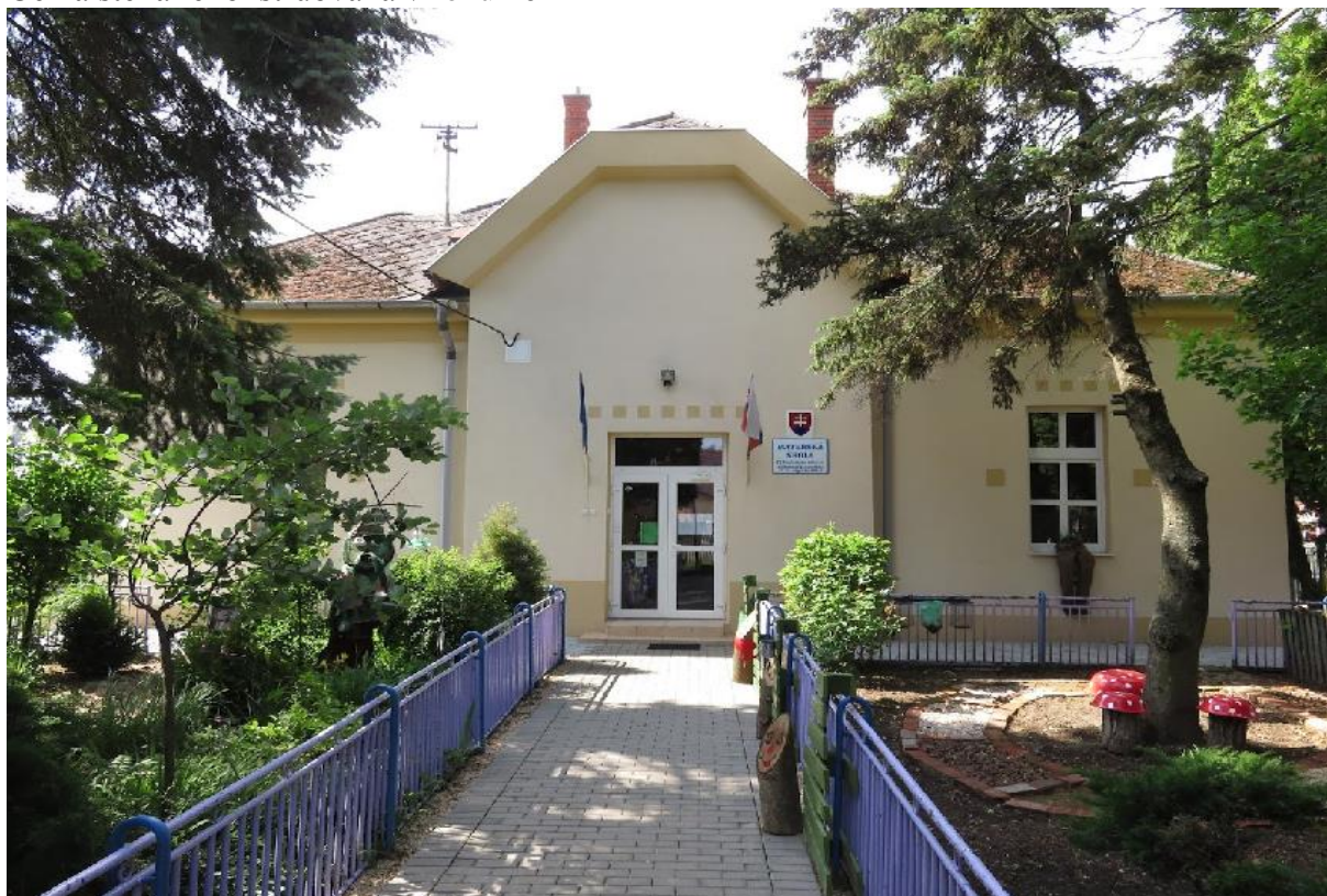
Budova MŠ na ul. 29. augusta Čelná stena rekonštruovaná v roku 2014
