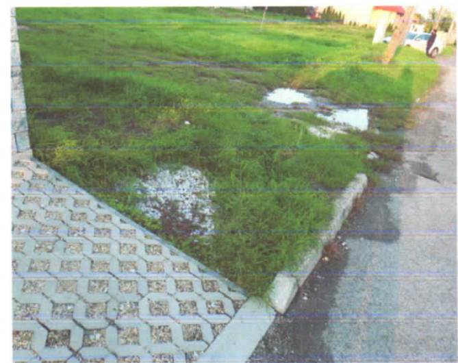
Celkový pohľad na bod napojenia na plynový rozvod
